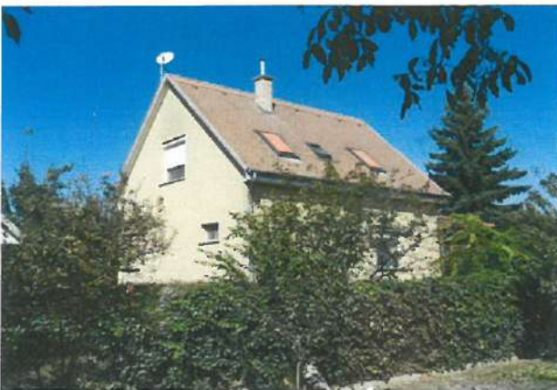
lakóház hátsó- és oldalhomlokzata - Barackfa u.
