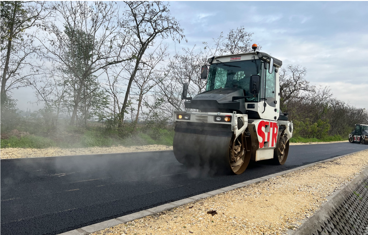
Útépitések, felújítások 6 km hosszban
