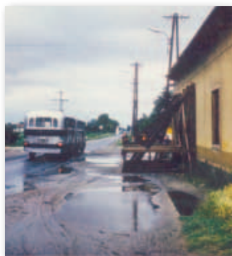
A kitámasztott fal a buszmegállóban
