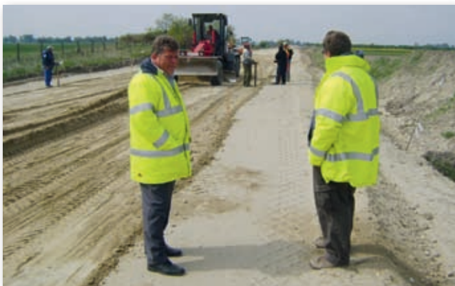
Épül a Gerincút Szigetszentmiklósi szakasza
