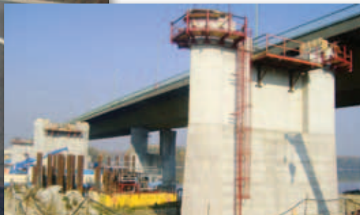
Egy elkészült ártéri pillér a szigeti oldalon
